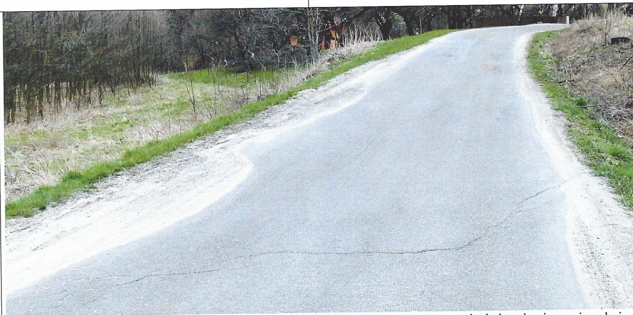
Zniszczona droga powiatowa w środkowej części osuwiska – widoczne wyraźne ugięcie i spękania nawierzchni (widok od S)
