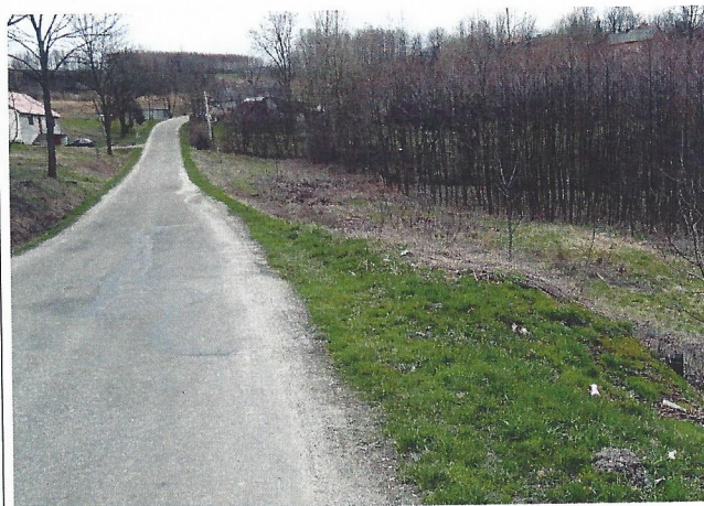
Zniszczona droga powiatowa w środkowej części osuwiska – widoczne ślady napraw (widok od N)
