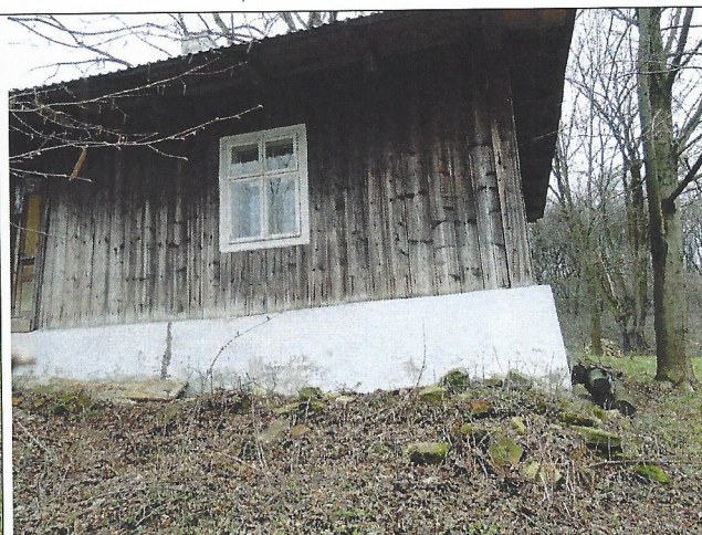
Skarpa boczna osuwiska przechodząca przez dom z widocznymi spękaniami
