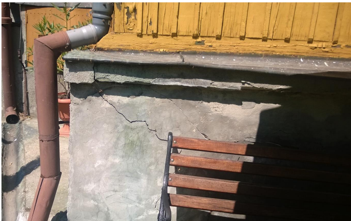
TARAS. WIDOCZNY ZNISZCZONY MUROWANY NAROŻNIK TARASU.
