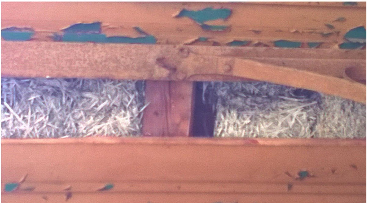
WERANDA ODKRYWKA WYKONANA OD SPODU ORAZ WIDOCZNY STALOWY ZAŚTRZAŁ PODPIERAJĄCY SZYNĘ.
