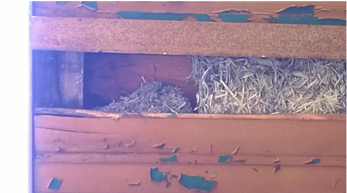
WERANDA ODKRYWKA WYKONANA OD SPODU W PODŁODZE. WIDOCZNA SZYNA KOLEJOWA I OPIERAJĄCA SIĘ NA NIEJ ZEWNĘTRZNA BELKA DREWNIANA O PRZĘKROJU 15X14 cm. WYPEŁNIENIE PRZESTRZENI POMIĘDZY DESKAMI PŁYTAMI Z SUPREMY UŁOŻONEJ LUZEM.
