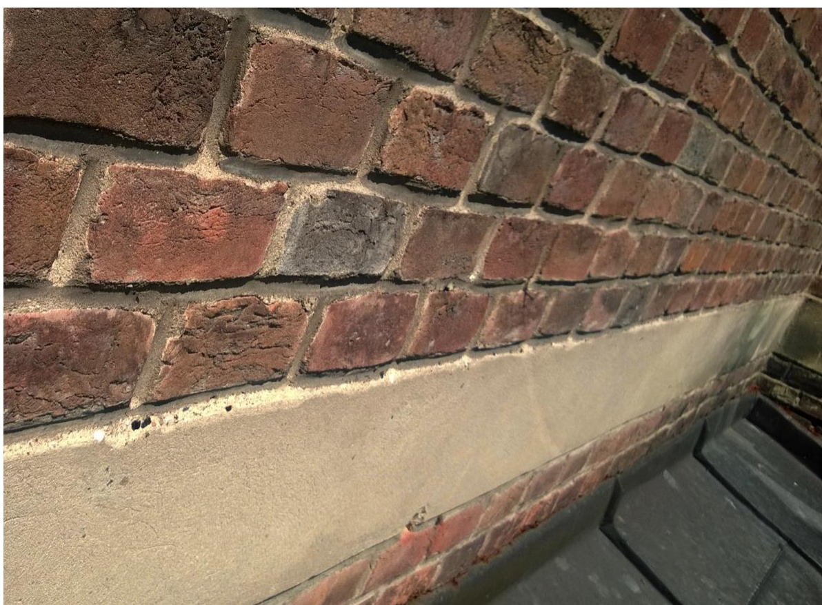
TARAS. WIDOCZNY ZNISZCZONY MUROWANY NAROŻNIK TARASU.
