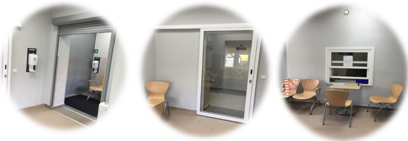
Przystosowanie pomieszczenia na punkt obsługi klienta w Powiatowym Zespole ds. Orzekania o Niepełnosprawności w Ropczycach
