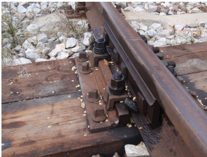
Fot. 17: Nasiona kaukaskich barszczy mogą przenosić się wzdłuż szlaków komunikacyjnych (I. Sachajdakiewicz).
